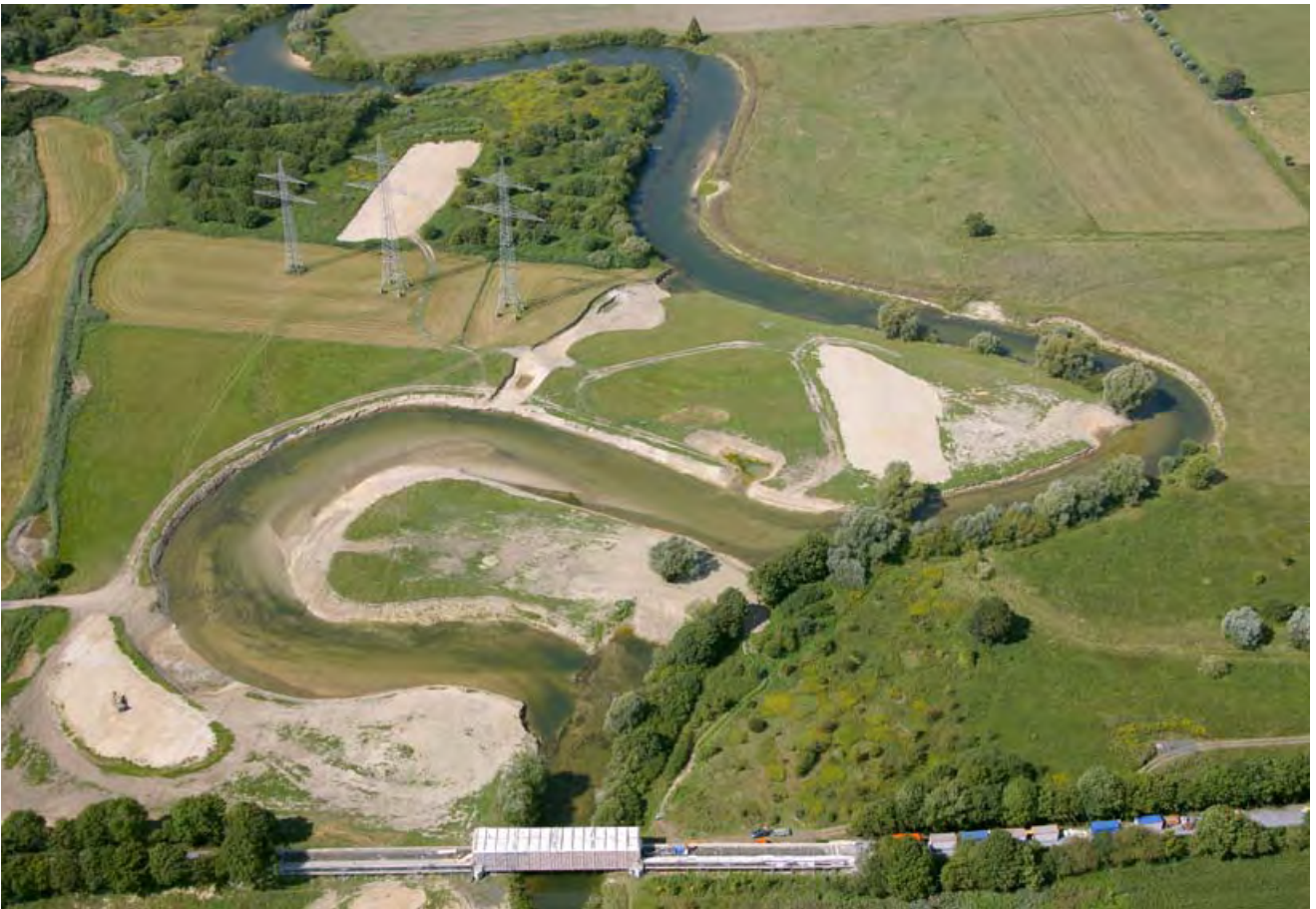
Die Laufverlängerung der Lippe in Maßnahmenblock D liegt flussabwärts der Brücke der ehemaligen Zechenbahn im Vordergrund des Bildes. Von oben wird deutlich, dass die Lippe in der neue Schlinge viel breiter und flacher ist als der alte Flusslauf.
