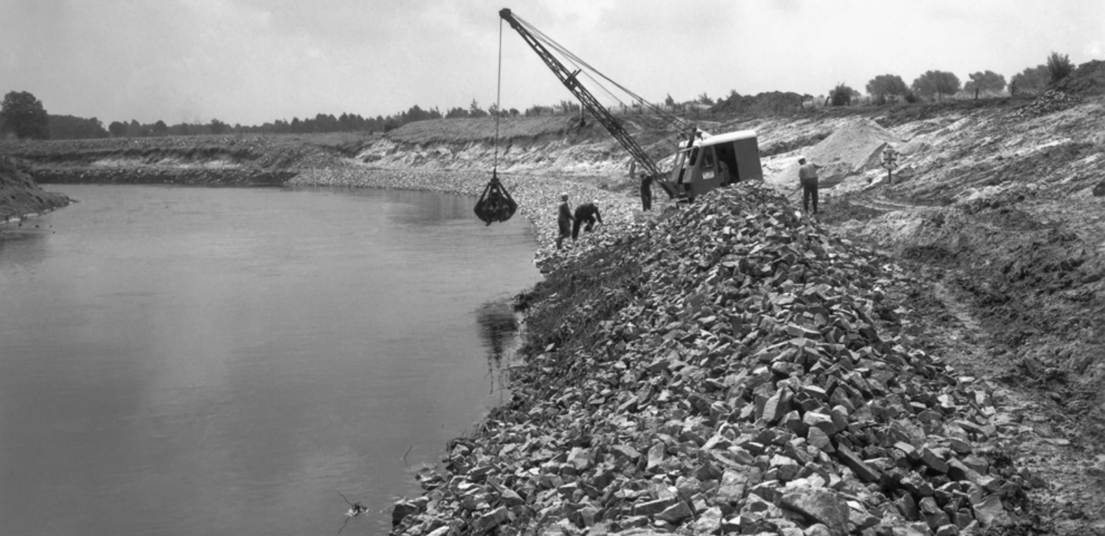
Ein Bild aus den 1960er Jahren: Ein Baurtrupp des Lippeverbandes sichert einen Prallhang.
