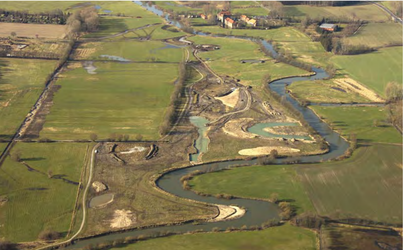
Block C als Baustelle: Der Weg ist im Kern des Auenraumes bereits vom Ufer der Lippe nach links in die Wiesen verlegt, der Fluss entfesselt und verbreitert. In der Bildmitte modellieren Baufahrzeuge neue Gewässer und errichten den Beobachtungshügel.
