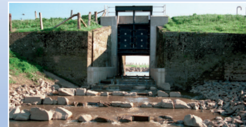
Fischtreppe in der Dornicker Schleuse
