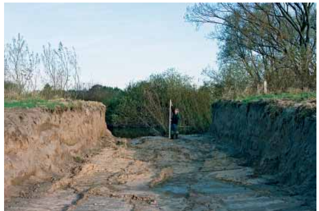
Um die Rinnen an die Lippe anzubinden, wurde die künstliche Verwallung bis zu 2 m tief durchbrochen.
