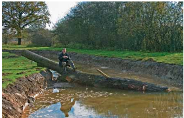
Totholz erhöht die Strömungsvielfalt und löst das Entstehen von Kühlen aus.
