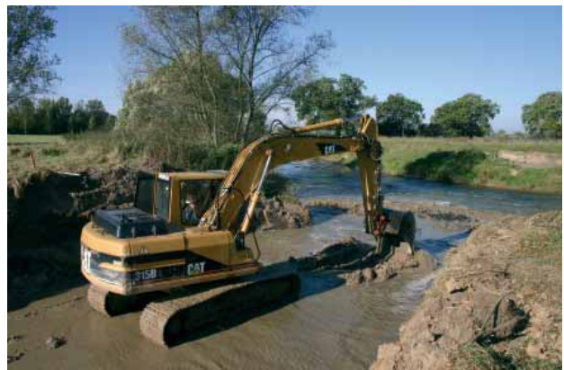
Der Mündungstrichter wird hergestellt.
